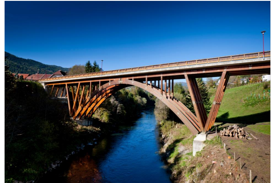
Holz – Europabrücke, größte freitragende Holzbrücke Europas
